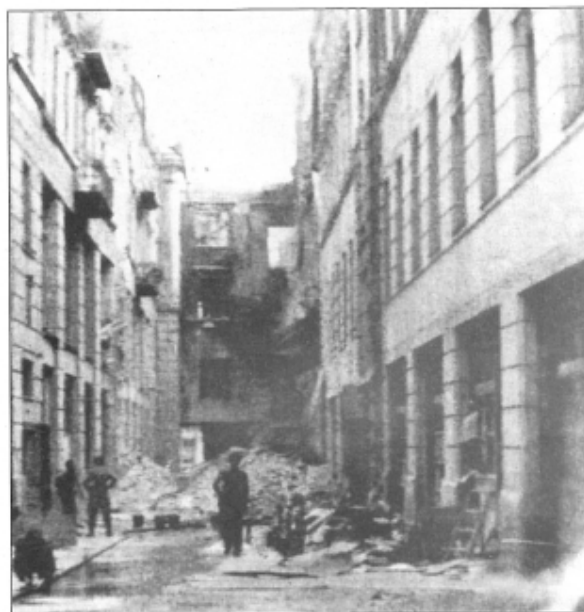
217. Zniszczone częściowo budynki Pasażu Simonsa, róg ul. Długiej i ul. Wylot. Fot. Józef Karpiński
